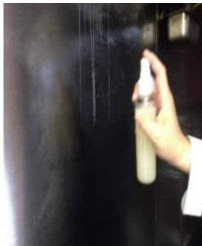
フライヤー後ろ壁面
